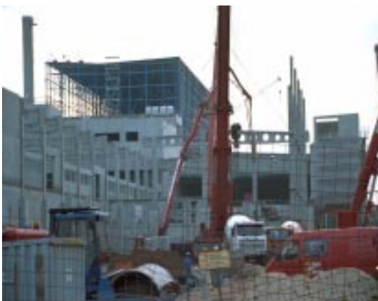
Das Gebäude in der Bauphase – ein mächtiger Koloss
