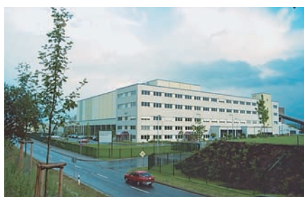
Das Gebäude der Palla Textil Holding erhielt innen und außen eine sinnvolle Gestaltung. Es wurde die Identität des Unternehmens unterstrichen sowie die ursprünglichen Betonwände in die Umwelt integriert.
