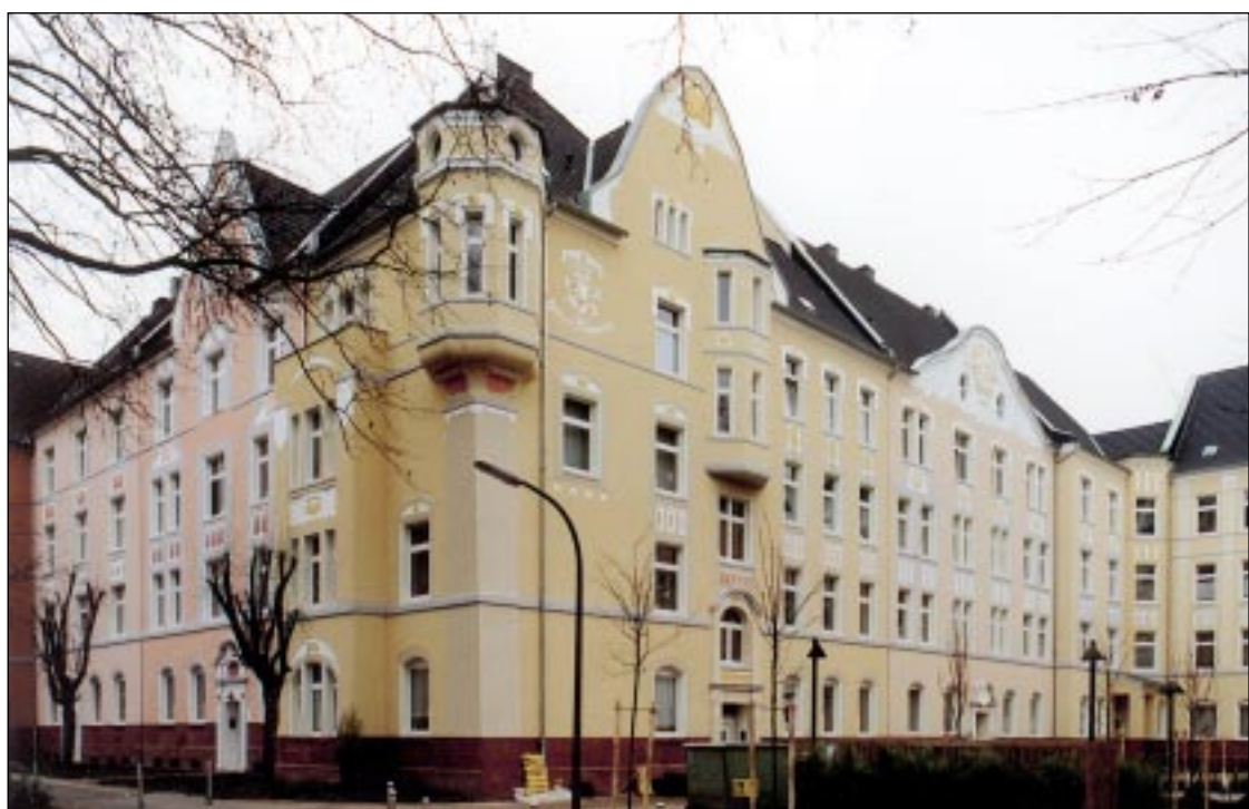
Ansicht Rittershausstraße 13-31 nach der Modernisierung 2001
